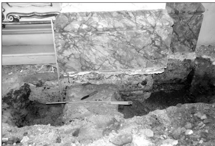
7. fotó: A diadalív vonalában feltárt lépcsőalapozás. A függőleges mérőléc a templomhajó járószintjén áll
