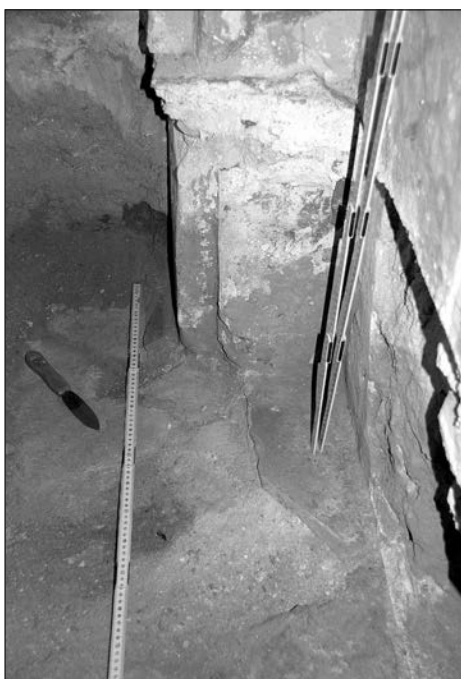
1. fotó: A XIX. századi járószint alatt feltárt barokk padló alapozási habarcsa (ezen fekszik az észak felé mutató spakni) és a kiugró pillér és fal sarkában megmaradt kelheimi burkolat töredéke (ezen áll a függőleges zollstock). Jól látszik a fotó felső részén a korábbi falsíkhöz képest előrebb ugró a szint emelés után kialakított fal, amelynek felszínén található a Franz Xaver Bucher által készített kifestés
