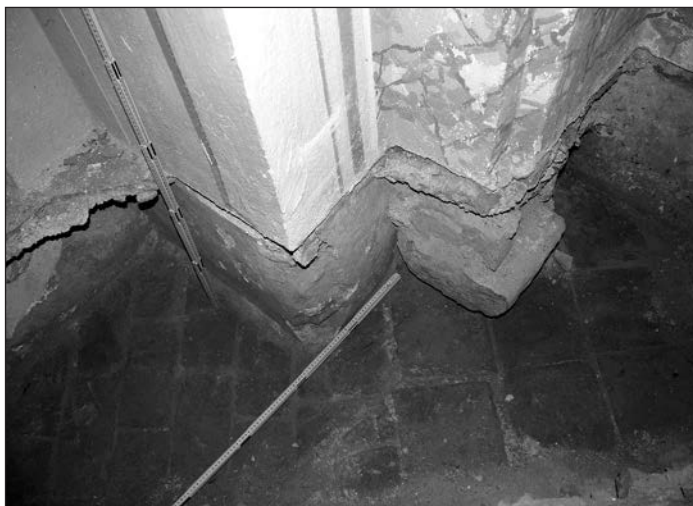
4. fotó: A falsarokban a Bucher-féle festéssel díszített tagolt karzatpillér alatt előkerült a ko-rábbi, a kelheimi burkolat hordására kialakított téglapadló. Jól látszik, hogy a későbbi pillért úgy alakították ki, hogy azt részben a korai padlóra helyezett faragott kövekre alapozták (a fek-vő mérőléce vége mutat a másodlagosan alapként felhasznált kövekre)
