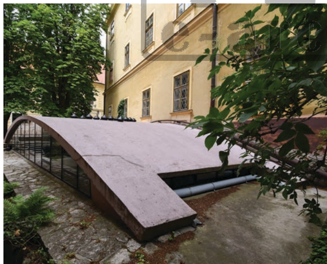
53. kép A modern védőépület keletről
