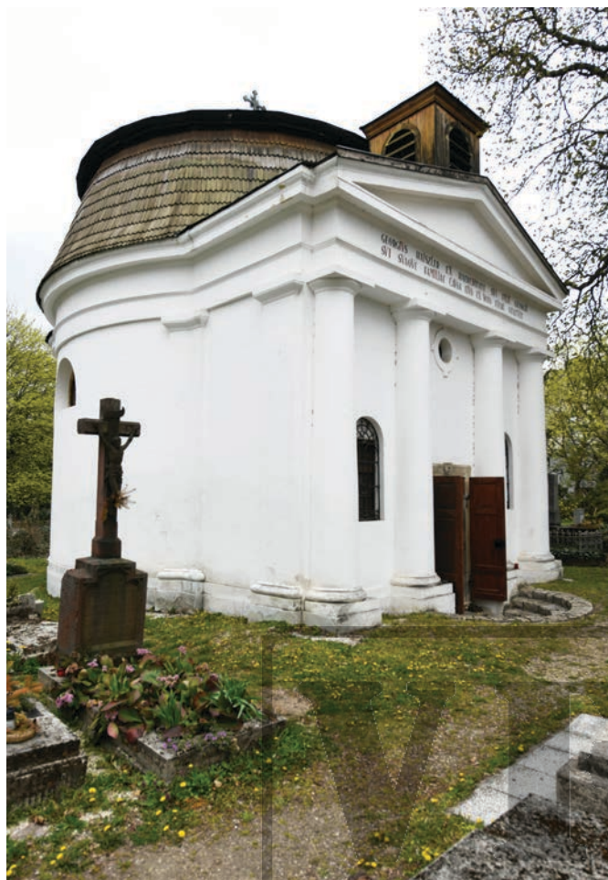
147. kép A kápolna főhomlokzata
