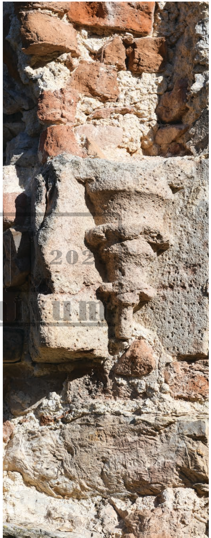
125. kép Tárcsás boltozatindító konzol az egykori oldalkápolnában, a szentély északi falán
