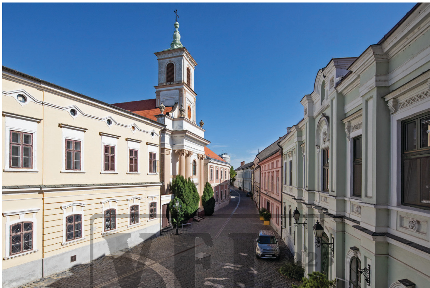
82. kép A piarista templom homlokzata az utcaképpen
