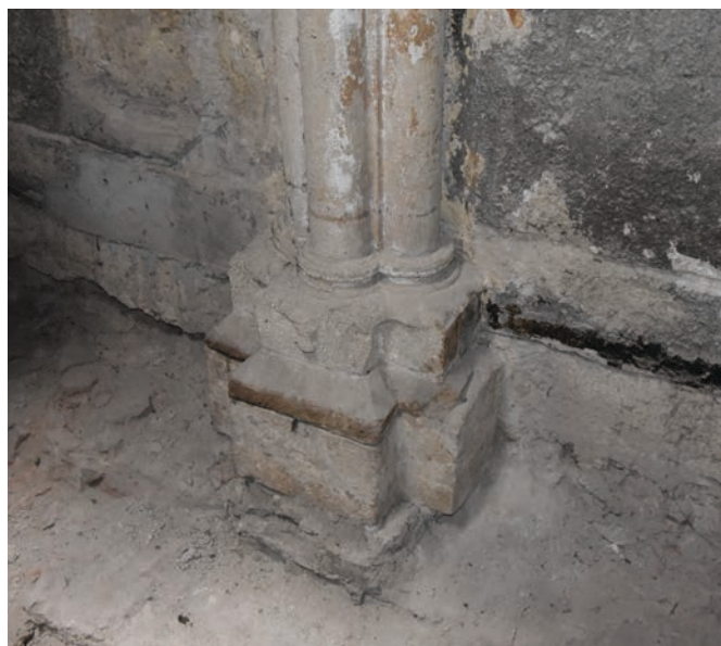
66. kép Az egykori felső kápolnahajó falpillérének lábazata
