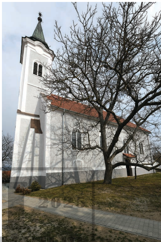
216. kép A templom oldalhomlokzata
