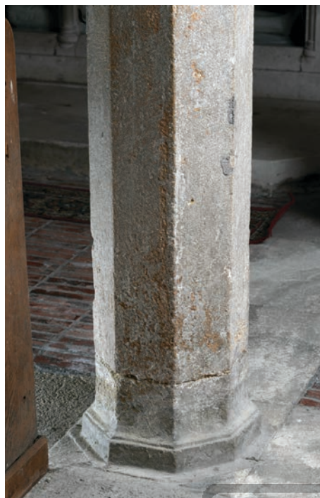
35. kép Pillérlábazat az altemplomban
