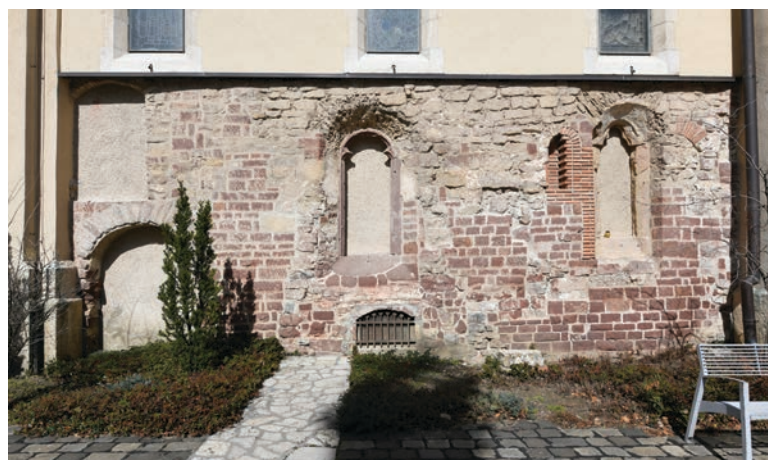
13. kép 11-13. századi részletek és átépítések nyomai a déli oldalhajó homlokzatán, a falazatok és a bal szélső nyílás korai, középen és a jobb szélén két utólagos ablak
