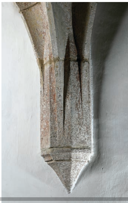
36. kép Boltozatindítás az altemplomban
