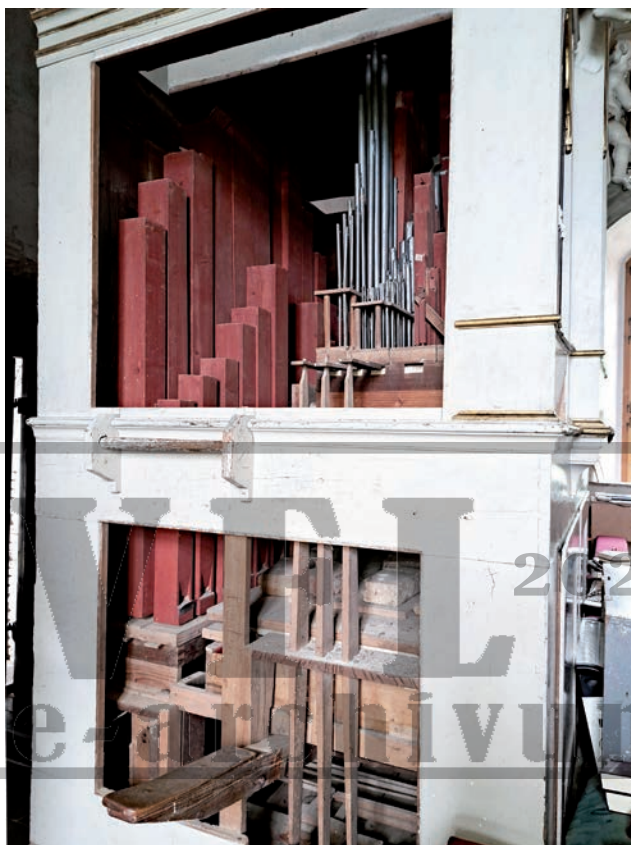
6. kép: A magyarpolányi orgona szerkezete, fűvója és sípműve. (a szerző felvétele, 2024)
